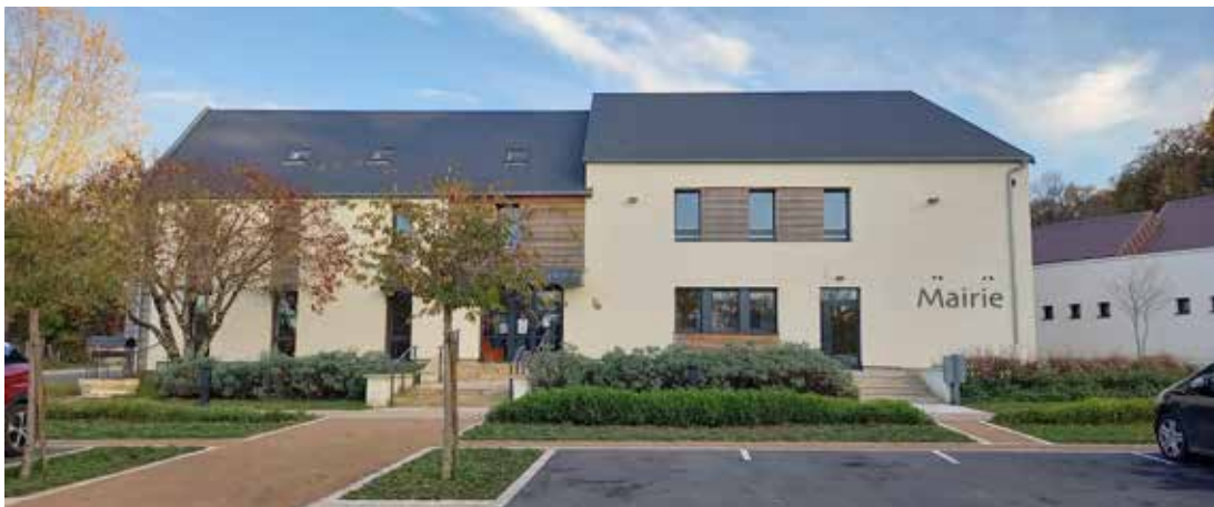
Accompagnement et conseil dans la rénovation de la mairie de Pigny (isolation murs et plafonds, remplacement de la chaudière par une pompe à chaleur, remplacement des menuiseries et des éclairages)
