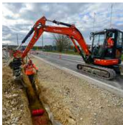
Extension des réseaux rue de France au Subdray sur environ 200m du réseau basse tension pour l'alimentation d'un C4 [appellation Tarif Jaune] d'un bâtiment de bureaux et entrepôt.
