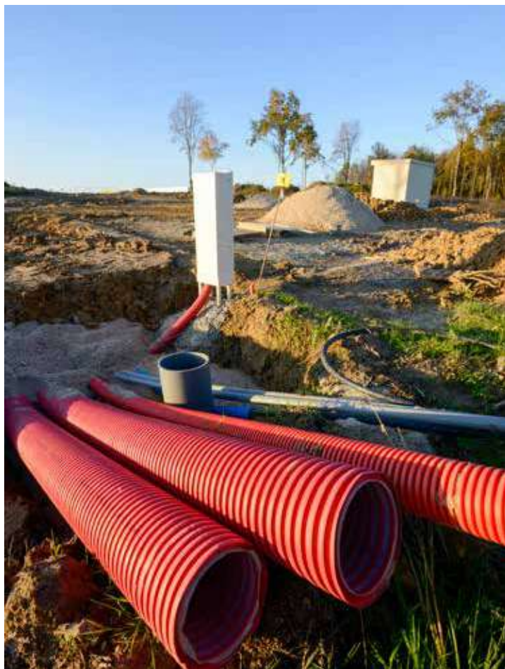
Travaux d'extension sur la zone d'activité de Quantilly avec la création de 2 postes de transformation, la création de 850 m de moyenne tension et 760 m de Basse tension en souterrain.
