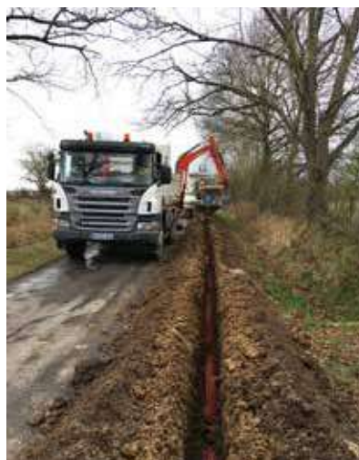
Renforcement en technique souterraine sur 1000 m au poste «Bois» et 470 m en aérien sur la commune de Saint Pierre les Bois avec la dépose de 1600 m de fils nus basse tension.
