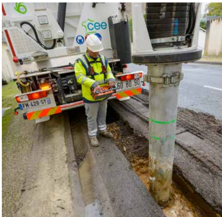
Renforcement des réseaux basse tension à Lignières avec l'utilisation d'une aspiratrice pour l'exécution de la tranchée.
