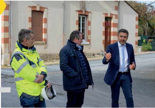
Visite du chantier d'enfouissement de Saint Just
