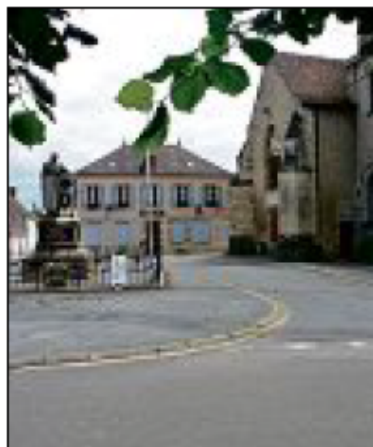
URBANISME. La place de la mairie fait partie des travaux d'aménagement du cœur historique de la ville.
