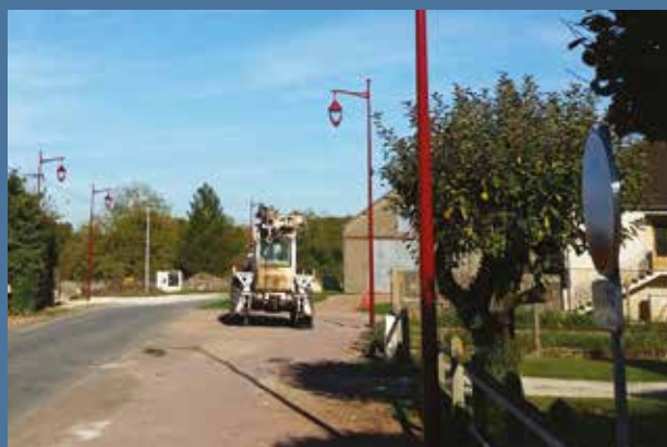
Travaux de dissimulation à Lugny-Champagne
