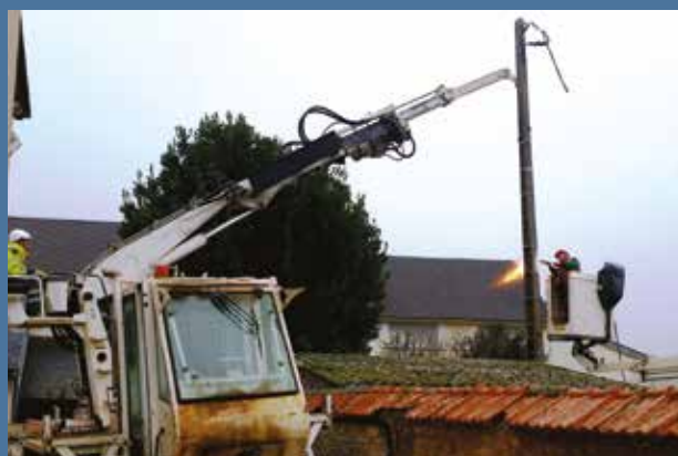
Dépose d'un poteau à Moulins-sur-Yèvre
