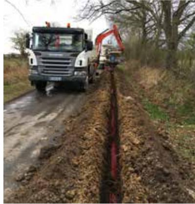
*Renforcement en technique souterraine sur 1000 m au poste «Bois» et 470 m en aérien sur la commune de Saint Pierre les Bois avec la dépose de 1600 m de fils nus basse tension.*
