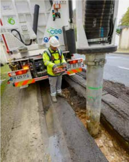
*Renforcement des réseaux basse tension à Lignières avec l'utilisation d'une aspiratrice pour l'exécution de la tranchée.*
