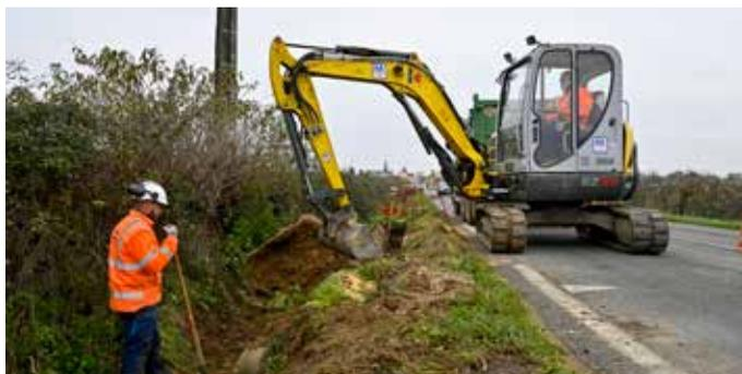
*Renforcement souterrain des réseaux basse tension à Thaumiers*
