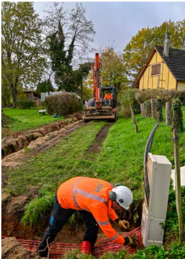
Travaux d'extension des réseaux électriques.
