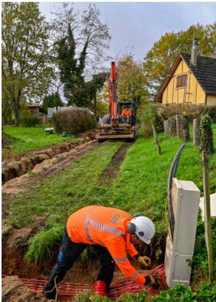
Travaux d'extension des réseaux électriques.
